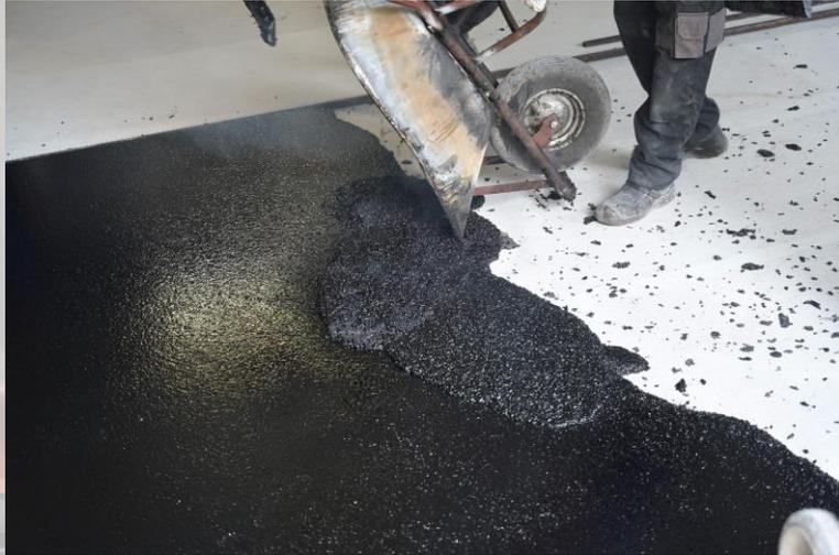
Einbau von Gussasphaltestrichen im Regelfall **von Hand**, auch auf größeren Flächen.
