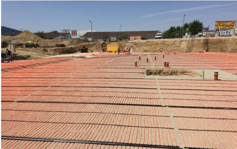
Der Erdspeicher wird im Erdreich unter der Sauberkeitsschicht verlegt.
