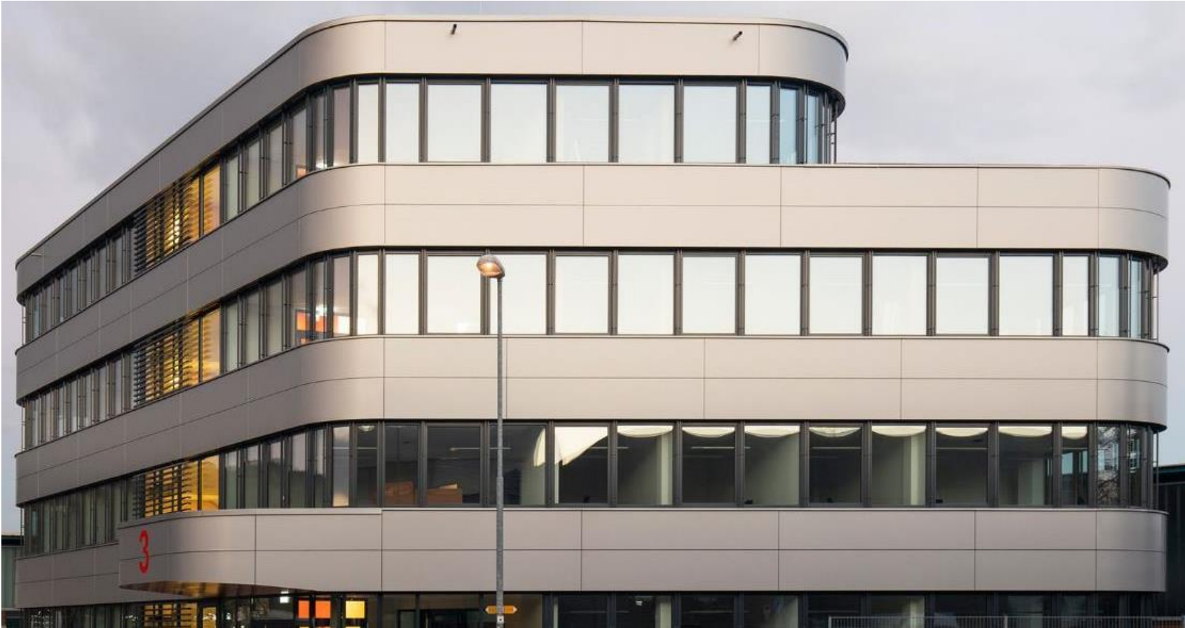
B3 Linnig Bürogebäude // BODAMER FABER Architekten BDA
