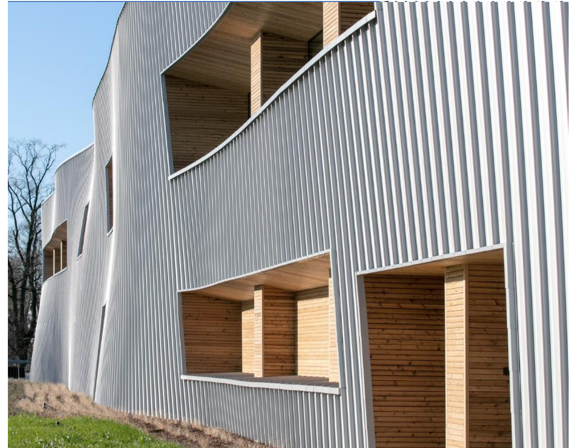
Sportcenter Blonie // Polen // ALSTAL Grupa Budowlana Sp. Z o.o.
