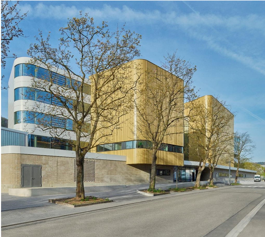
Thermenhotel Bad Ems // Architektur: 4a Architekten GmbH Stuttgart
