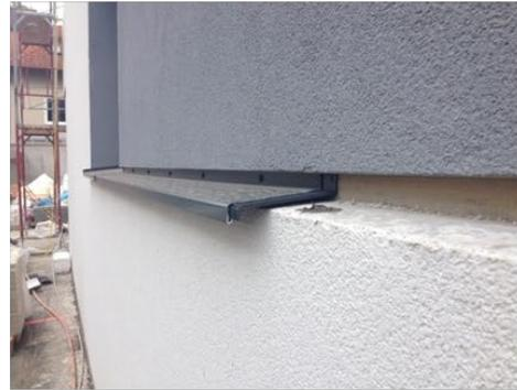
Vorgefertigtes Unterbauelement zur Befestigung von Sohlbankblechen
