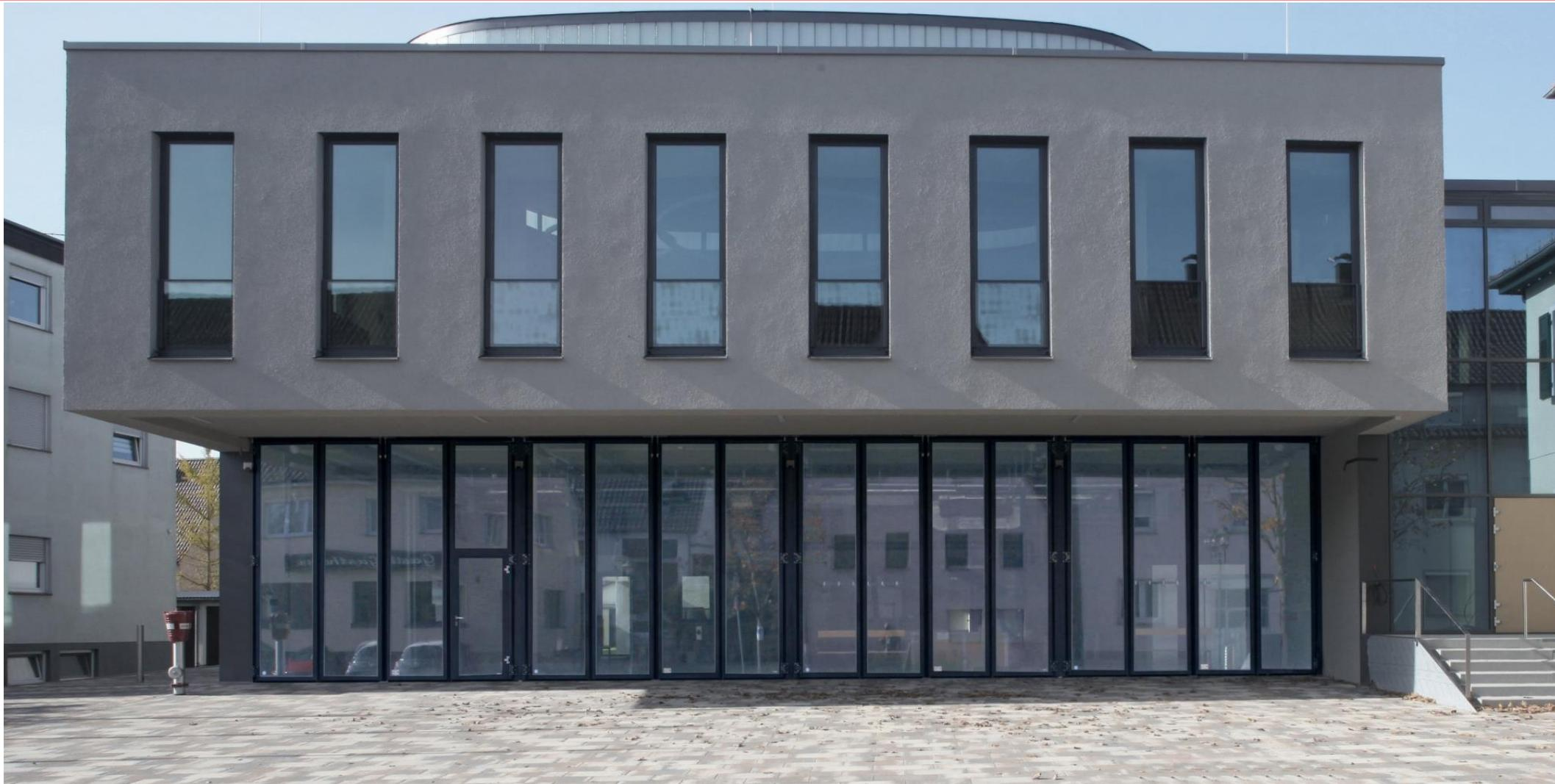
FEUERWACHE WIESBADEN-IGSTADT MIT 17 VOLLVERGLASTEN TOREN MIT SONNENSCHUTZVERGLASUNG UND SONDERFAHRTS
